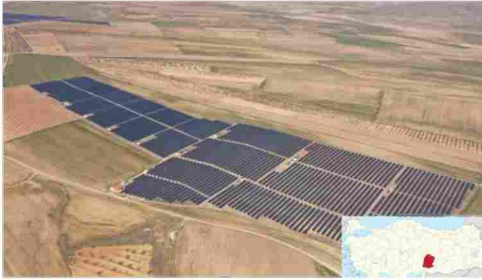
Elbistan GES (Kahramanmaraş)
